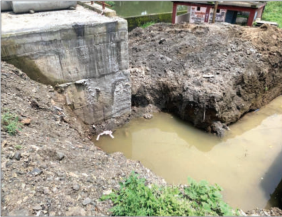
गूंज की खबर के बाद तोड़ा गया ब्रिज निर्माण का घंटिया निर्माण वाला हिस्सा।
